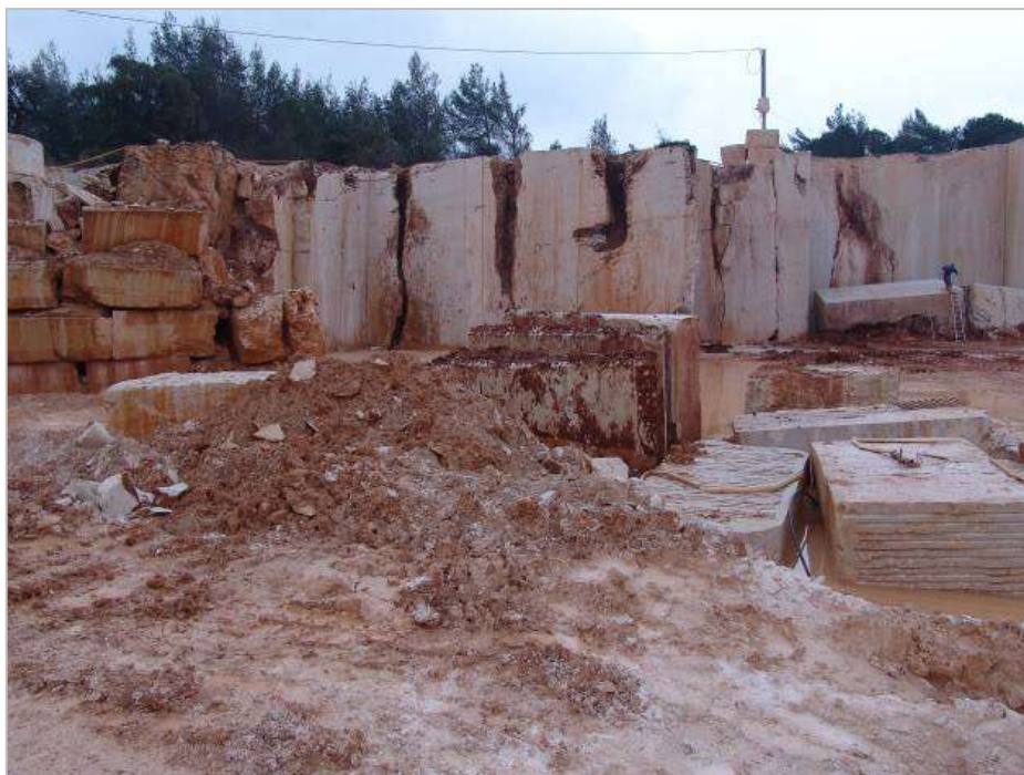
Figura n.º 76: Talude Norte da exploração
