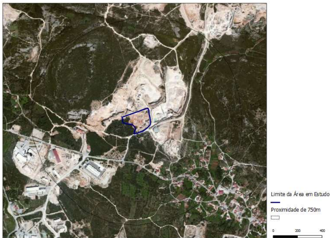
Figura n.º 36: Fotografia aérea da envolvente à área em estudo, com uma escala mais reduzida.
